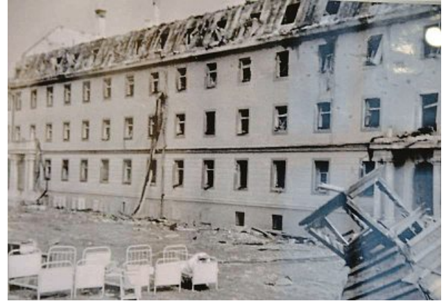
Das Kolleg nach dem Bombenangriff 1943. Die Betondecke verhinderte, dass das Gebäude restlos abbrannte. Alle 1100 Fenster gingen zu Bruch. Auch den Wiederaufbau des Kollegs hat Lothar König organisiert.
