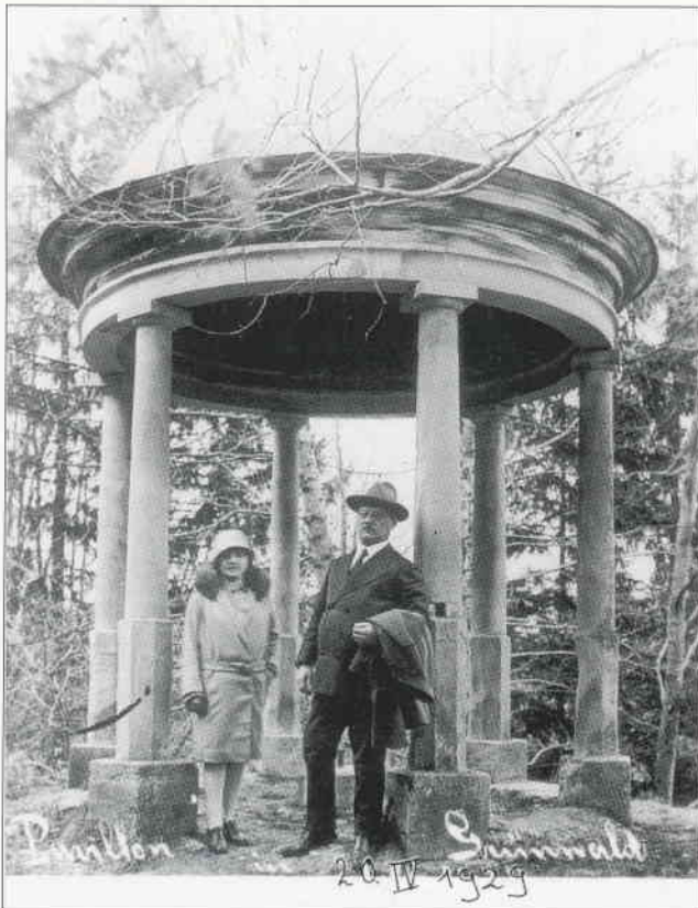
Links: Die einzige bekannte Fotografie des Monopteros vor seiner Zerstörung zeigt das Bauwerk, das einen Sockel aus Nagelfluh und Säulen aus Kalkstein besaß.
