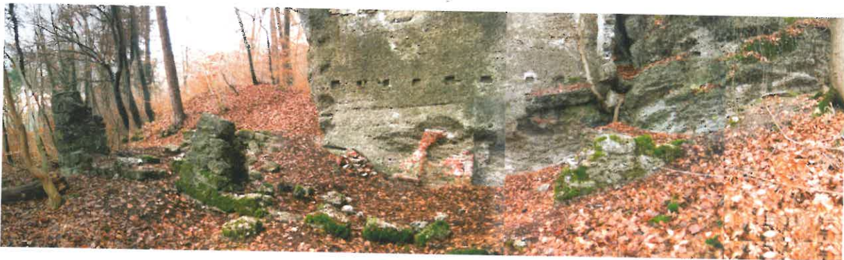
Abb. 290: Ruine der so genannten „Bierhütte“ (eigene Aufnahme 2003)
